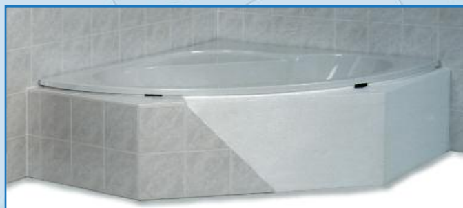
Eckwannenträger kurz vor Abschluß der Verfliesung
